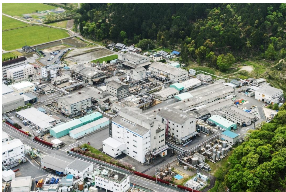
第一工業製薬 滋賀工場全景
