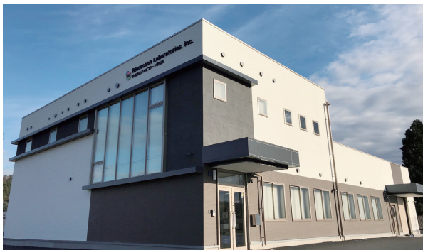
竣工した棚倉工場
