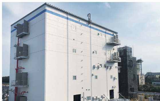
四日市事業所霞工場 機能材料製品製造設備
