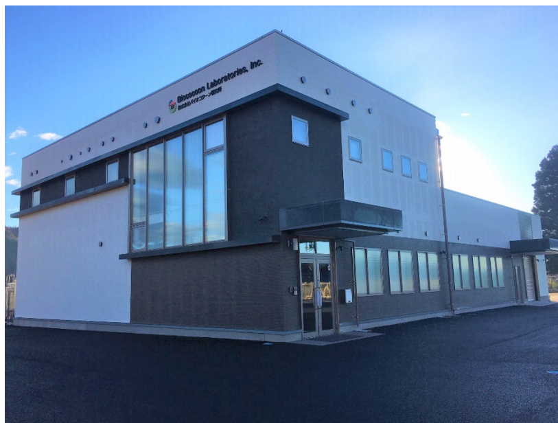
竣工した新工場棟
