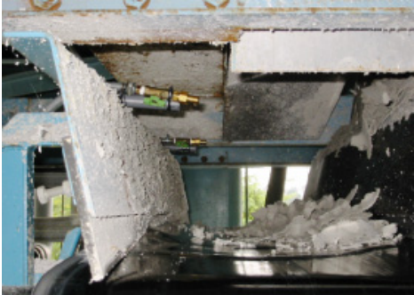
脱水ケーキコンベアに散布
