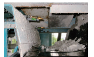
脱水ケーキコンベアに散布
