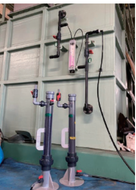
小型脱臭塔の仮設試験
