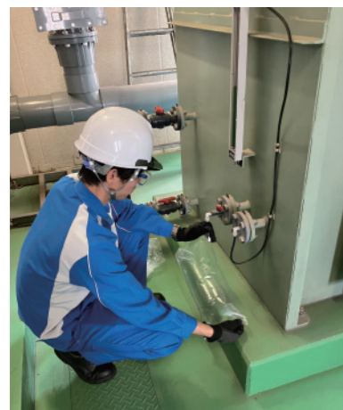
脱臭塔の臭気調査
