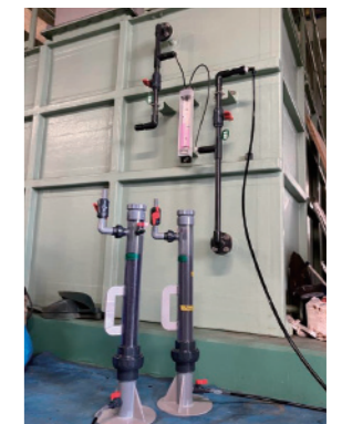
小型脱臭塔の仮設試験
