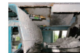
脱水ケーキコンベアに散布
