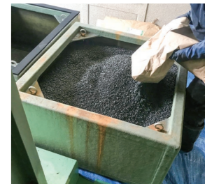
脱臭塔に充填
