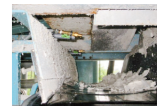
脱水ケーキコンベアに散布
