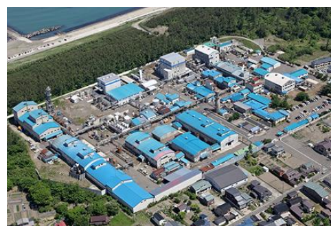
<第一工業製薬 大瀧工場>
