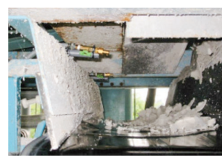
脱水ケーキコンベアに散布
