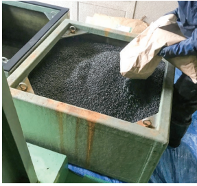
脱臭塔に充填
