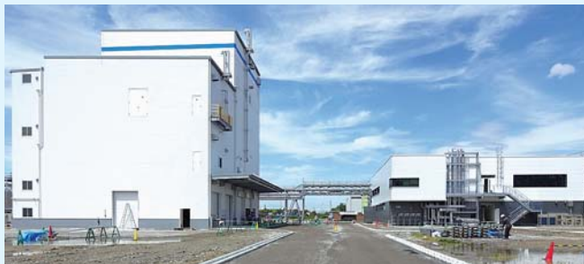
第一プラント(左)とコントロールセンター棟(右)の写真(平成27年5月)
