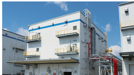
四日市事業所霞工場 ウレタン材料製品製造設備
