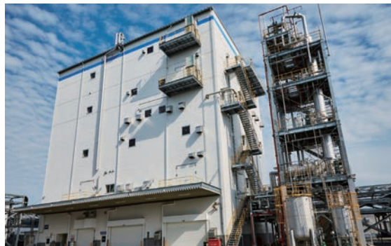
四日市工場霞地区 機能材料製品製造設備
