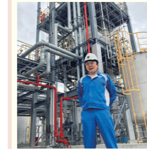
四日市工場 電第4プラント
