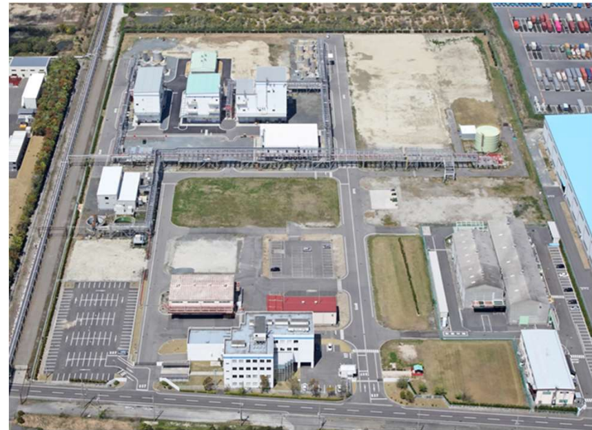
三重県四日市市 霞工場
